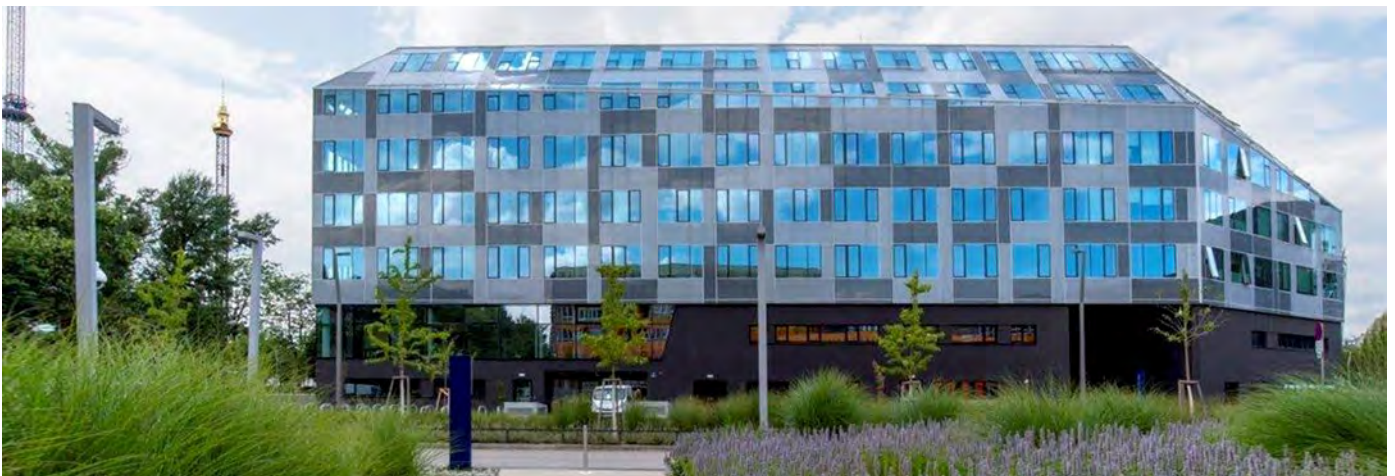
Neues Departmentgebäude D5
